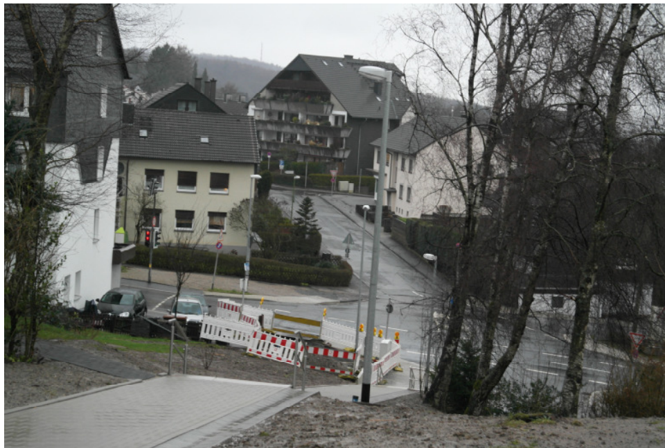
Blick aus Richtung Eichendorffstraße
