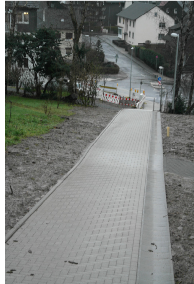
Blick aus Richtung Eichendorffstraße
