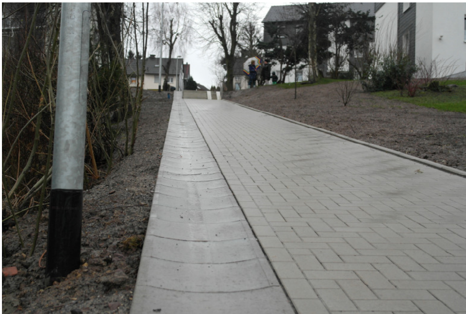
Blick aus Richtung Wilhelmshöher Straße
